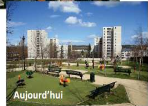
Opération de renouvellement urbain aux Tarterêts
