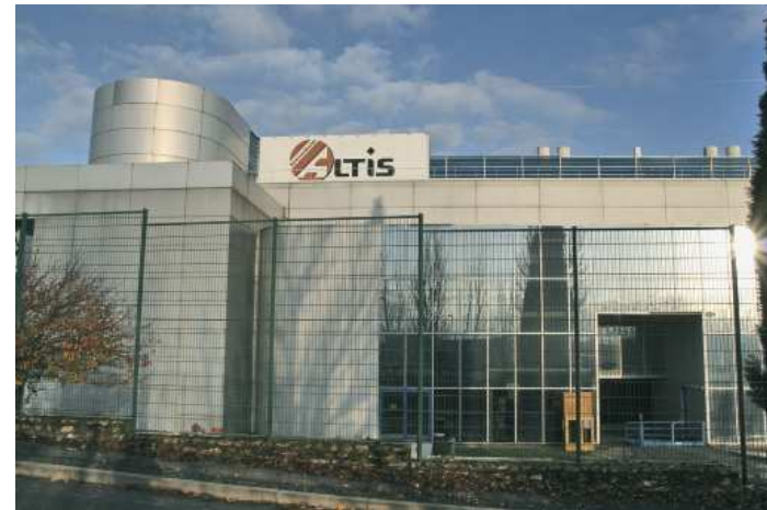
Usine ALTIS Source : Mairie de Corbeil-Essonnes, 2012
