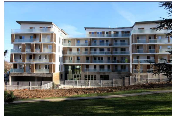
Nouvelles constructions sur le secteur de Montconseil
