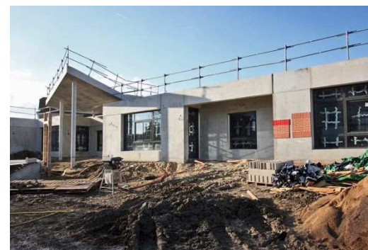
Construction de l'école Pasteur Source : Mairie de Corbeil-Essonnes, 2012
